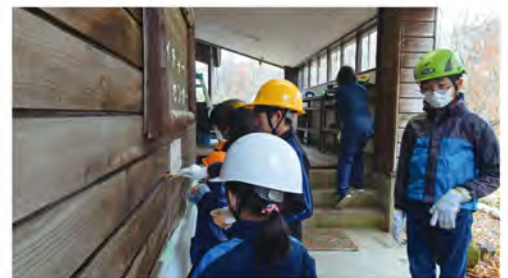
力をあわせて外壁にペンキを塗る
